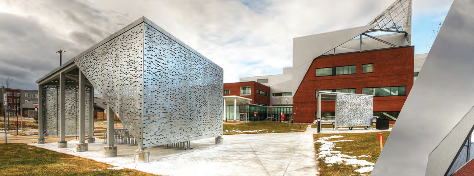
Nouvel hôpital, Baie-Saint-Paul
