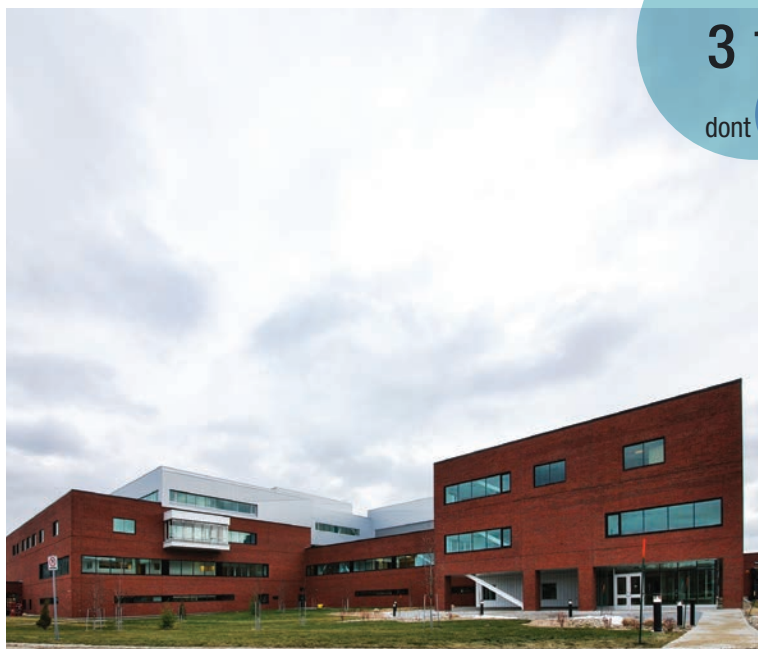
Hôpital de Baie-Saint-Paul © Lemay Groupe A (Guillaume Drouin-Chartier)
